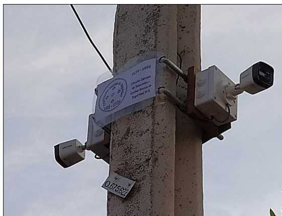
Circuito Cerrado de Televisión Instalado en UBS
